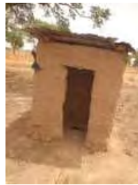
Vue extérieure avec le toit en tôle
