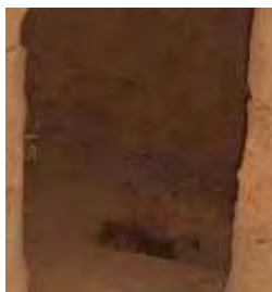
Vue intérieure (Trou du WC)
